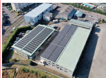
工場屋根に太陽光発電設備を設置
